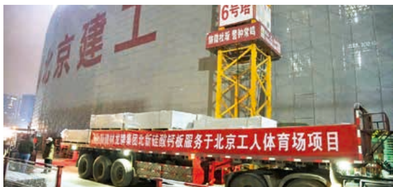
龙牌公司服务北京工人体育场改造项目
