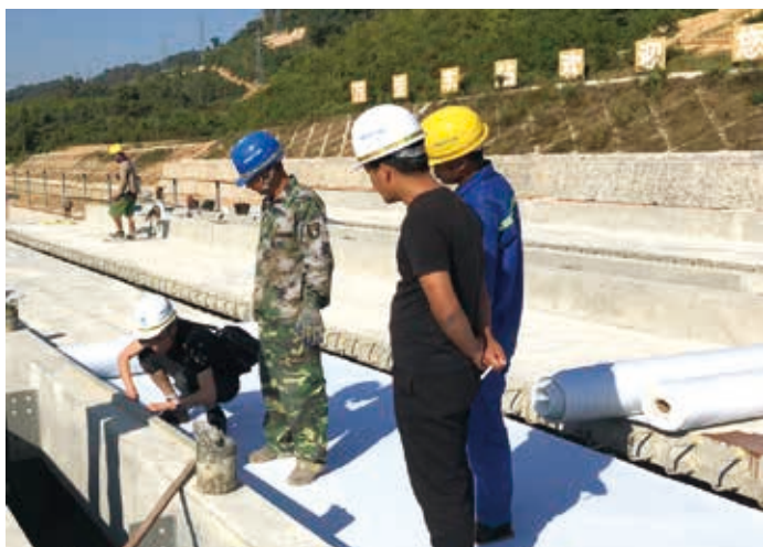
北新防水技术人员正在中老铁路施工现场做防水施工指导
