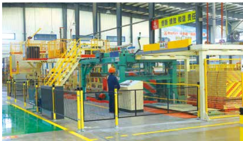
聊城公司石膏板生产线
