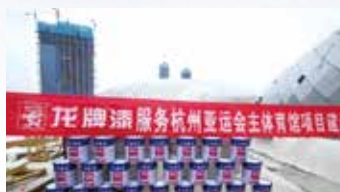
龙牌漆服务亚运会场馆建设
