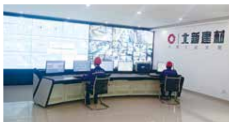
井冈山北新中控室
