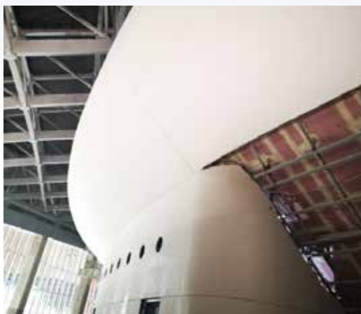
亚运会场馆无木吊顶系统照片
